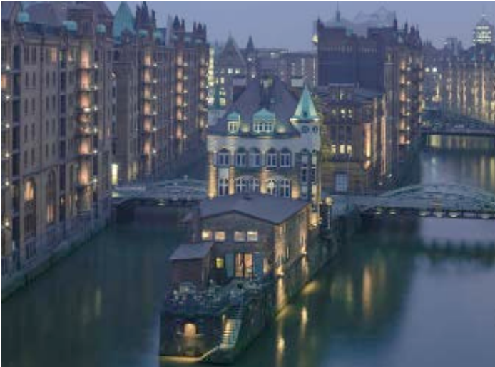
Illuminiertes Wasserschloss: Die Beleuchtung von Michael Batz setzt Akzente, aber Architektur und Struktur der Gebäude stehen im Mittelpunkt
