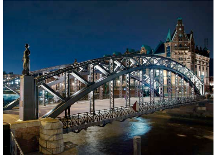
Stahlbau, in Szene gesetzt: Die Brooksbrücke ist besonders abends mit der Beleuchtung von innen heraus ein Blickfang
